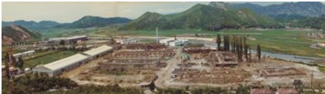
안양공장 공사현장 전경
