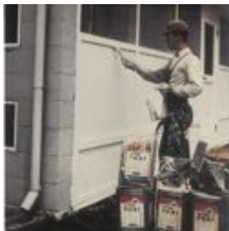
노루표페인트로 도장하는 미군부대 내 주택
