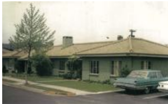
미군부대 내 주택 도장
