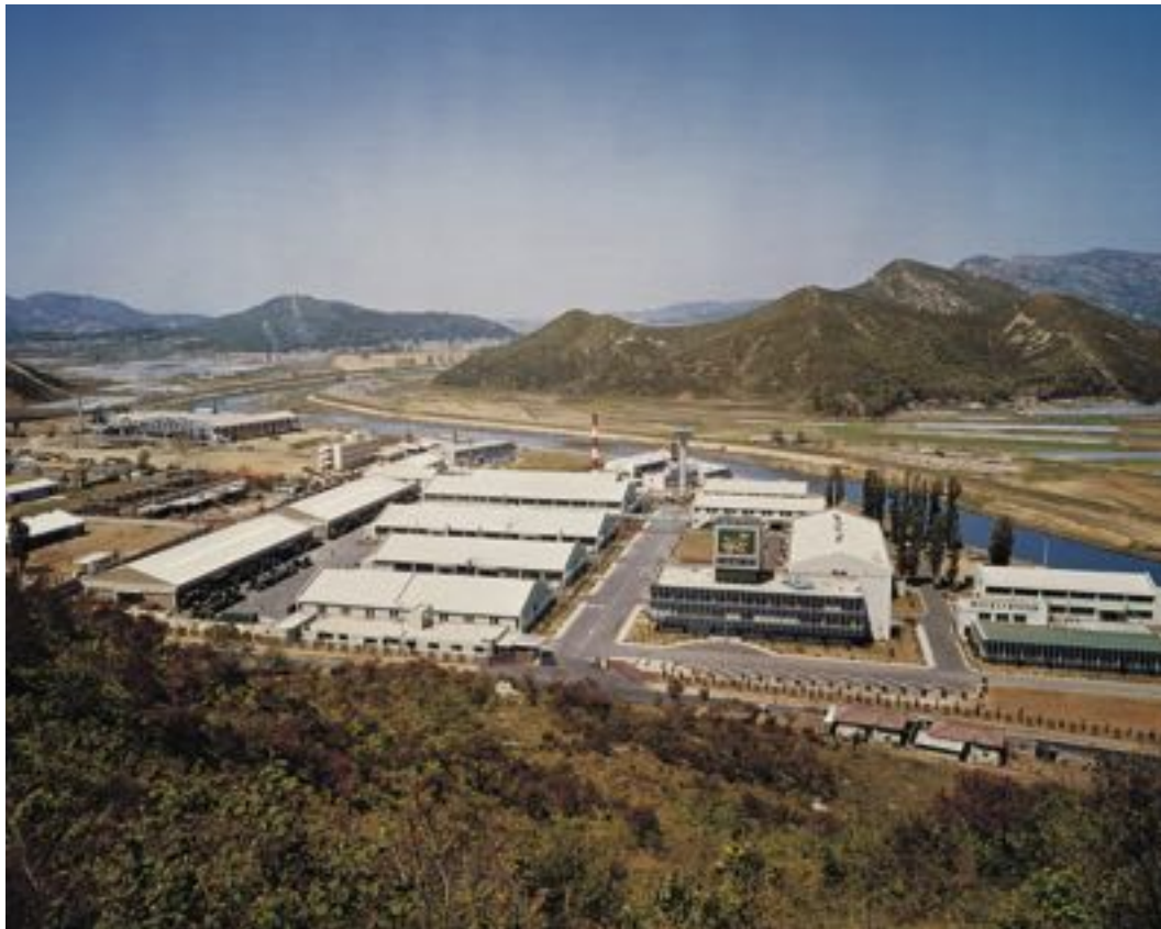
안양공장 전경(1976. 4. 1 준공)
